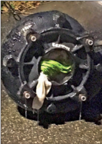
(Fotos: verschiedene Einsätze und immer wieder das gleiche Problem – Babywindeln, Bettunterlagen und neben weiteren Fremdstoffen auch Wischtücher)
