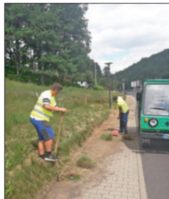
Grasnarbe abstecken, Bord freilegen, Fußweg reinigen
