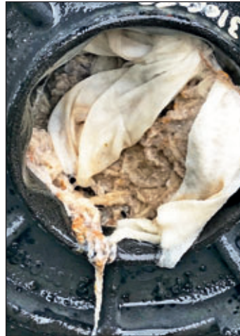
(Fotos: verschiedene Einsätze und immer wieder das gleiche Problem – Babywindeln, Bettunterlagen und neben weiteren Fremdstoffen auch Wischtücher)
